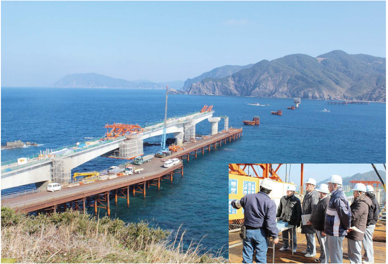
建設の進む蘭牟田瀬戸架橋(1月23日 建設水道委員会の現地視察)
