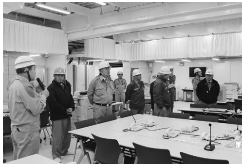
川内原子力発電所の代替緊急時対策所内部
