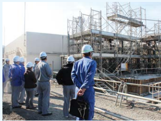
代替緊急時対策所待機所設置工事
