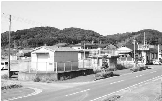
山田島排水ポンプ場
