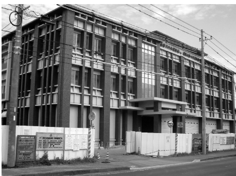
建設中の新消防庁舎(4月現在)
