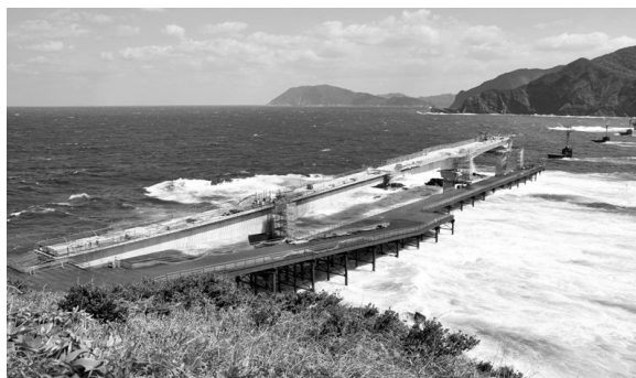
建設中の蘭牟田瀬戸架橋(4月現在)
