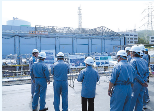
海水ポンプエリア防水対策工事
