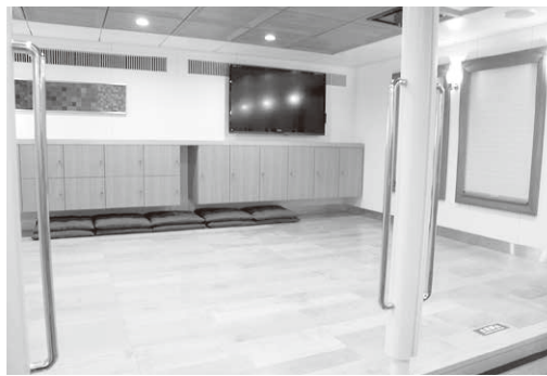
カーペットが敷設される高速船のフローリング部分
