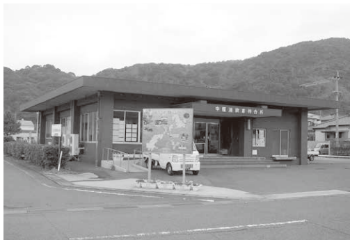
地域活性化施設として活用予定の旧中甌港待合所
