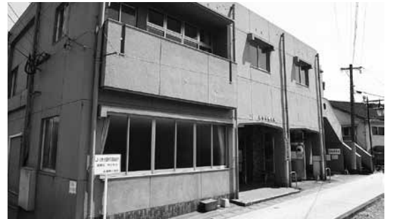
総合休養会館に併設されている下之湯公衆浴場(樋脇町市比野)
