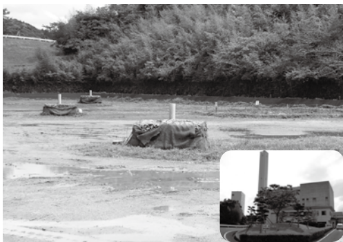
川内クリーンセンター最終処分場
