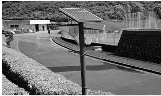
産学官連携により開発された独立電源型LED灯 (総合運動公園内)
