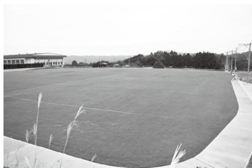
建設中の樋脇グラウンド・ゴルフ場(10月21日現在)
