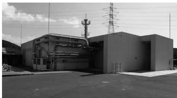
代替緊急時対策所(川内原子力発電所内)
