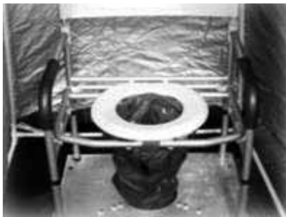
災害用マンホールトイレ
