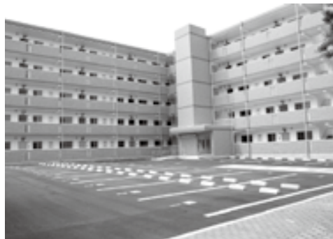
若葉市営住宅
