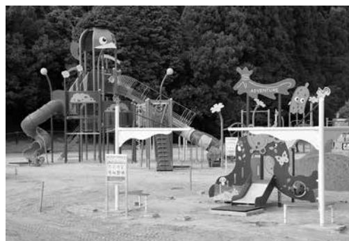
遊具老朽化により更新工事中のわんぱく広場
