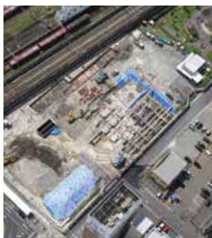
建設中のコンベンション施設
