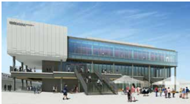
川内駅コンベンションセンター完成イメージ
