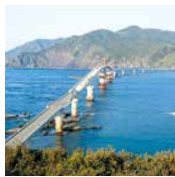
建設中の蘭牟田瀬戸架橋
