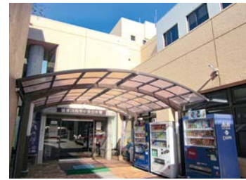
空調設備が改修される中央公民館
