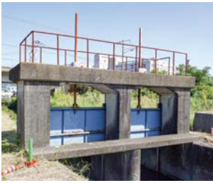
撤去される原田井堰
