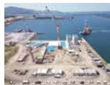
工事中の川内港
