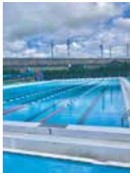
現在の川内プール
