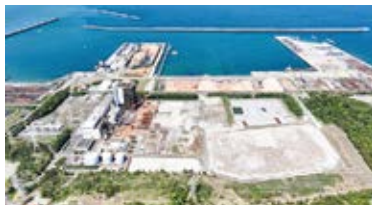
川内港背後地（全景）
