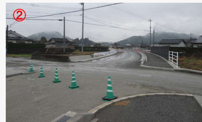
令和 6 年 2 月末現在（長崎堤防下付近）
