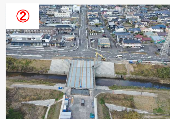
令和 6 年 1 月状況 平佐麓橋（令和 6 年 3 月竣工）
