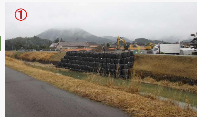
令和 6 年 2 月末現在（八間川橋梁工事）
