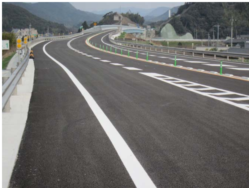
南九州西回り自動車道(隈之城道路)薩摩川内高江ICから小倉側を望む
