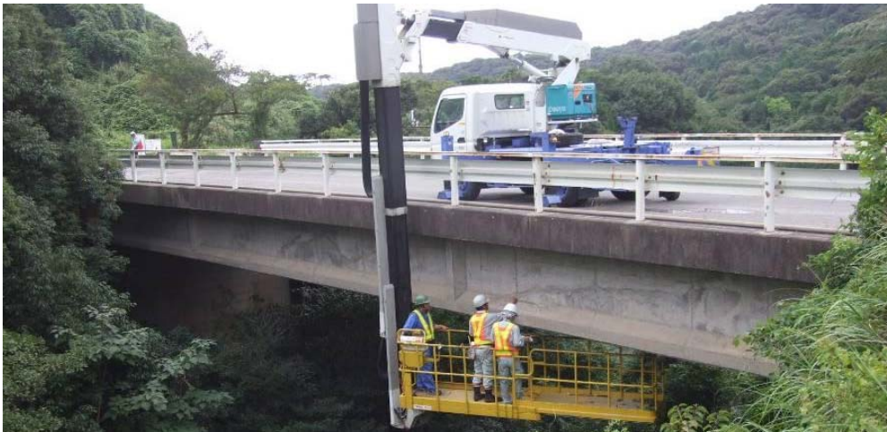
橋梁点検を実施
