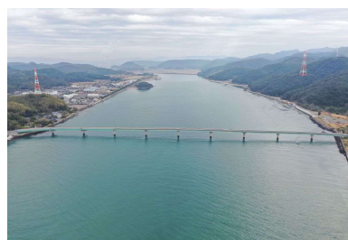
川内河口大橋
