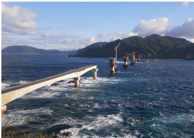
蘭牟田瀬戸架橋(建設中) H28. 12月 鹿島側より撮影
