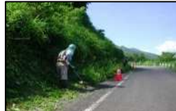
道路除草・管理
