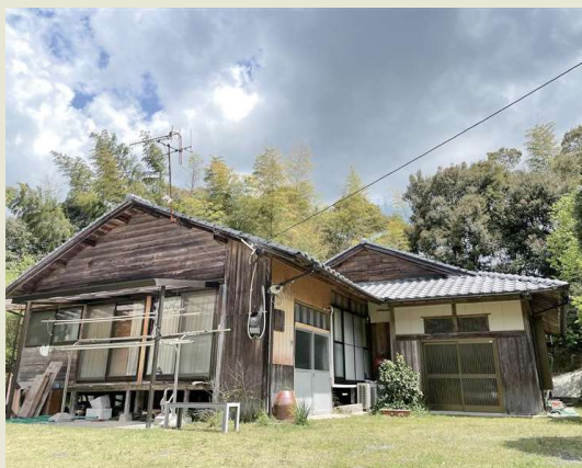
▲改修を行った空き家
