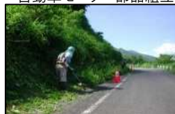
道路除草・管理
