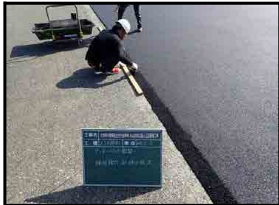
アンダーパット擦り付け状況
