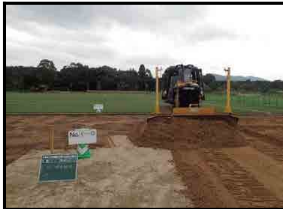
ICT機械掘削状況
