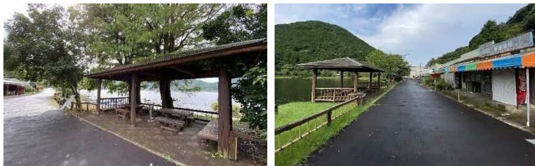
写真 2-24 老朽化している東屋（休憩所）
