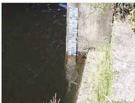
水門の量水板（0 点高標高=296.064m）
