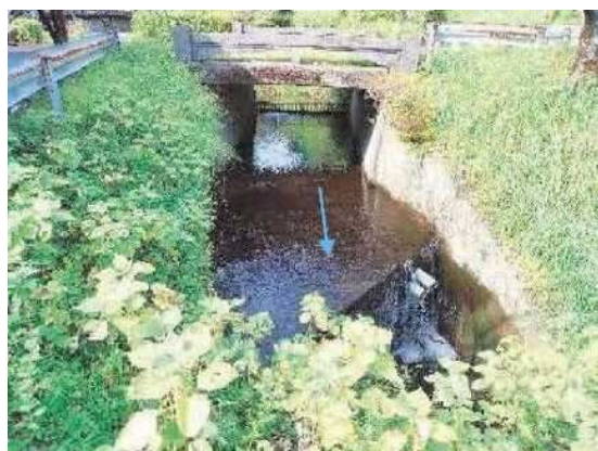
洪水吐から越流中 (撮影日：R4.10.21、水位 104 cm)
