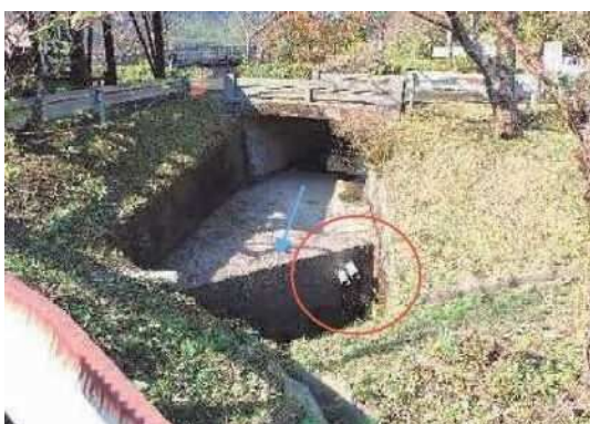
現状の越流式余水吐き（蘭牟田池）
