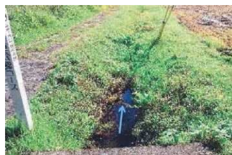
写真3-1 抽水植物に覆われる水路（保護上重要な種の生息地）
