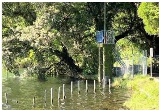
既存の取水樋門
