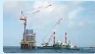
作業船・タワークレーンによる施工
