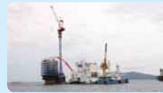
コンクリートミキサー船による コンクリート打設
