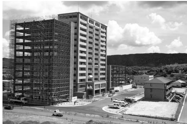
川内駅東口の高層建築物
