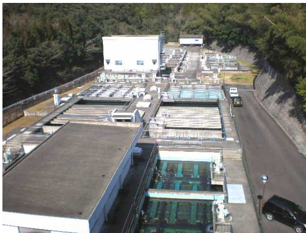
川内地域丸山浄水場（急速ろ過方式）
