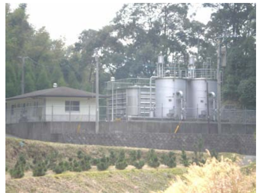
東郷地域中津俣浄水場
