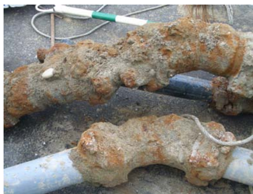
老朽管の取出状況
