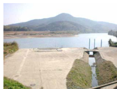
川内地域丸山取水口
