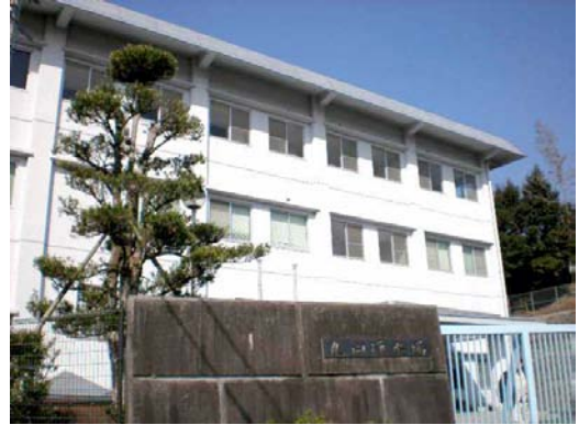
川内地域丸山浄水場管理棟
