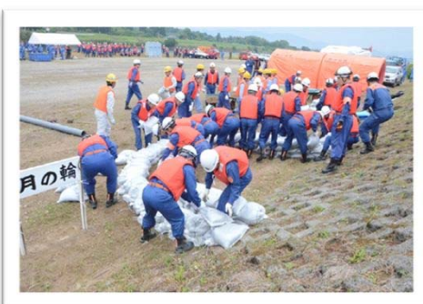
水防工法(月の輪工法)
