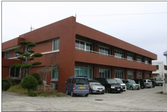
図書館里分館・里公民館
