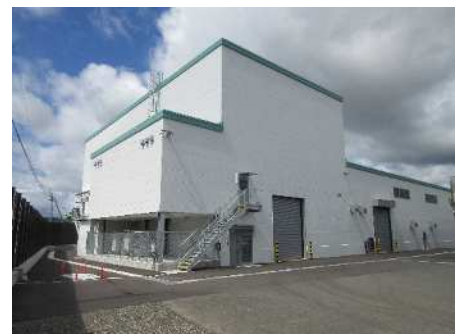
稼働中のセルロースナノファイバー商業プラント
